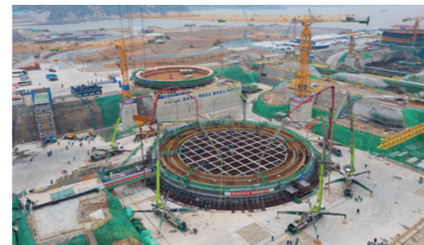
Die Bauarbeiten an der Hualong-One-Einheit Sanaocun-2 beginnen Ende 2021 offiziell. Somit sind in China 16 Einheiten in Bau. (Foto: CGN)
