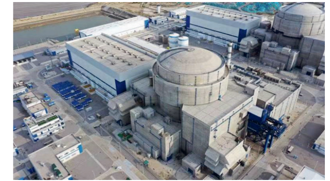
Fuqing-6 wird nach der Inbetriebnahme jährlich rund 10 Mio. MWh Strom produzieren. (Foto: CNNC)
