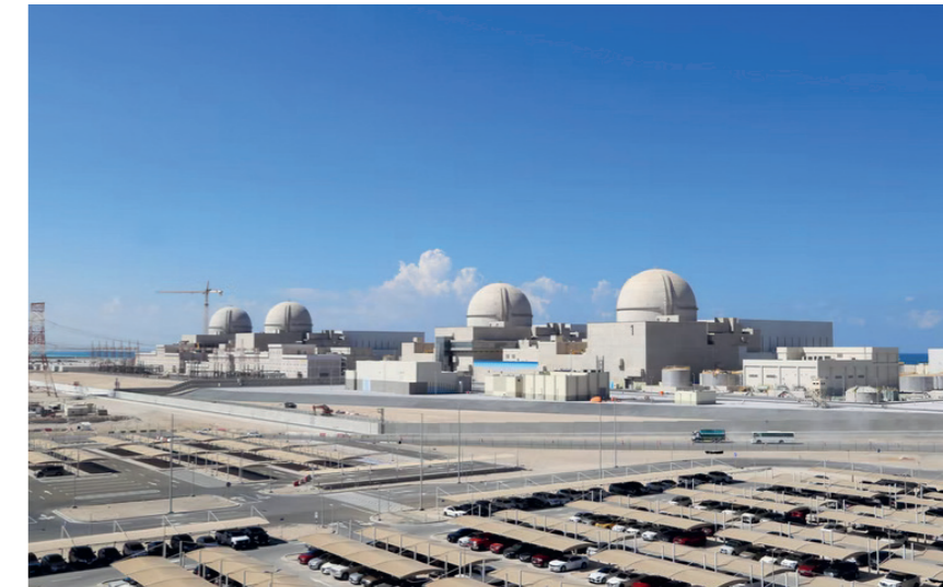
Am Standort Barakah in der Nähe von Ruwais in der Region Al Dhafra in Abu Dhabi sind vier südkoreanische APR-1400 vorgesehen. Barakah-1 nahm den kommerziellen Betrieb im April 2021 auf und Barakah-2 erzeugte Mitte September 2021 erstmals Strom. Die Bauarbeiten an Barakah-3 sind unterdessen beendet und Barakah-4 ist zu 91% fertiggestellt. (Foto: Emirates Nuclear Energy Corporation)
