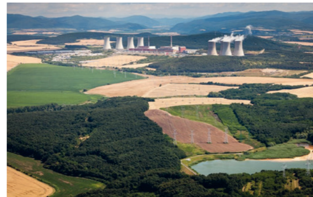
Luftaufnahme des Kraftwerks Mochovce in der Slowakei. (Foto: Slovenské elektrárne)
