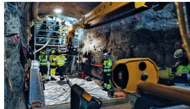
Stollen des finnischen Tiefenlagers Onkalo. Rund 400 Meter unter der Erdoberfläche werden ab 2025 ausgediente Brennelemente dauerhaft und sicher entsorgt. (Foto: Posiva)
