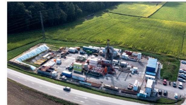
Die Bohrung Rheinau liefert weitere wichtige Erkenntnisse zur Sicherheit eines geologischen Tiefenlagers in der Nordschweiz. (Foto: Nagra)
