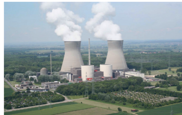
Deutschland: Gundremmingen-C sowie zwei weitere Kernkraftwerkeinheiten wurden Ende 2021 abgeschaltet. (Foto: RWE)
